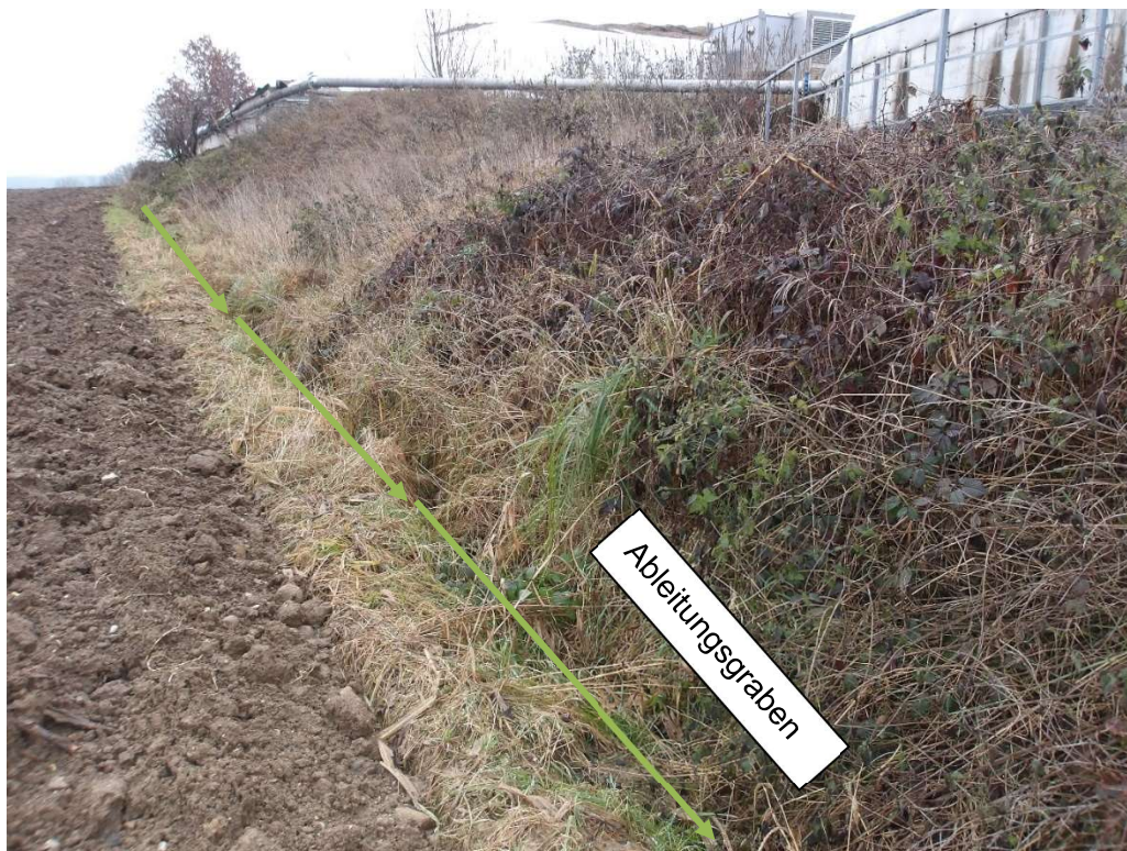
Abbildung 7: Ableitungsgraben in seinem weiteren Verlauf (1)
