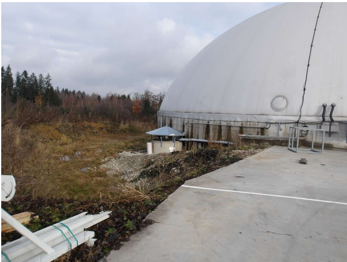
Abbildung 11: Havariebecken neben dem Gärrestlager 2
