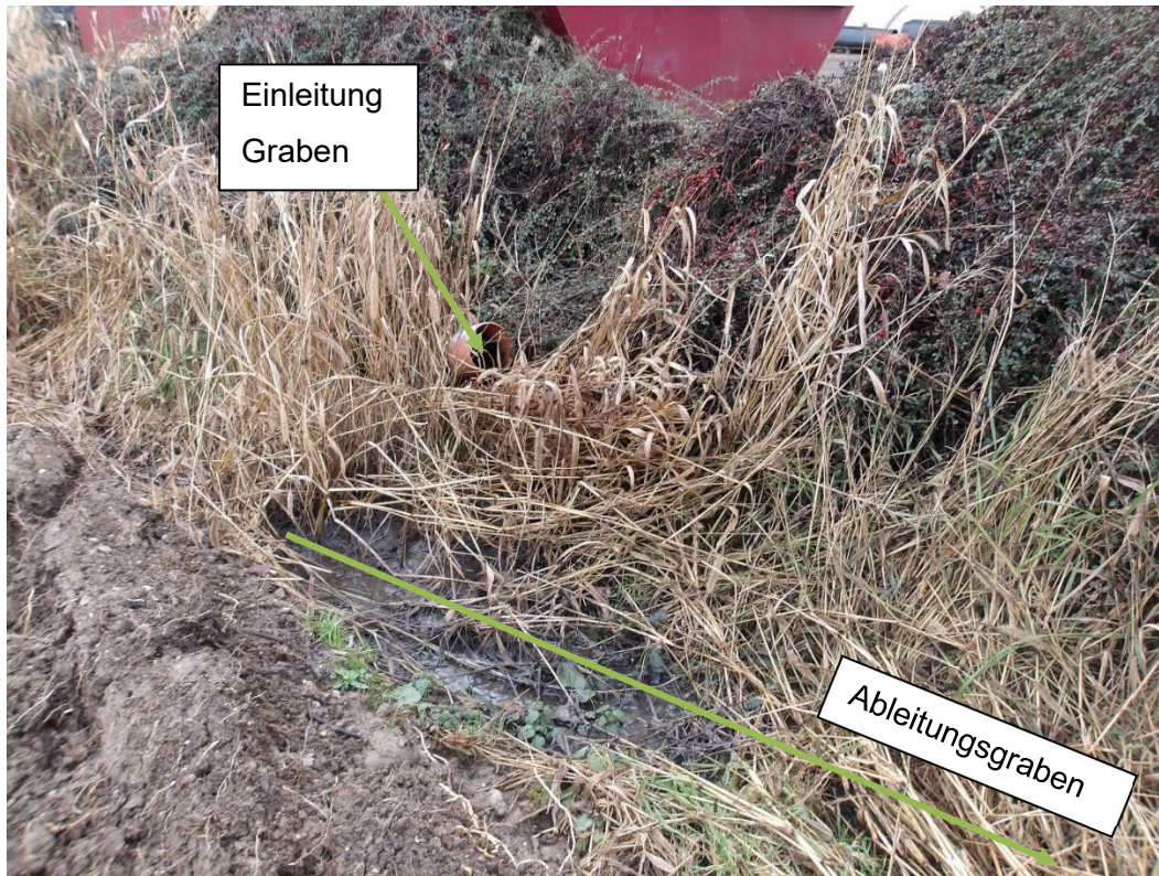
Abbildung 6: Einleitung aus dem Löschwasserbehälter in den Ableitungsgraben
